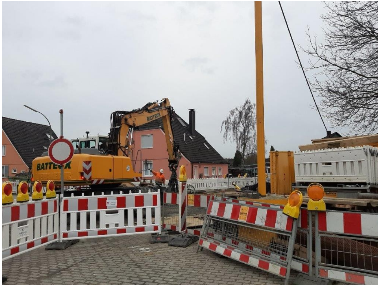
Aktuelle RAG-Baustelle Westfalenstr.
